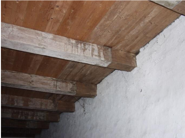
23 – 24. De onbeschilderde uiteinden van de zolderbalken wijzen op een afgeschoten deel boven de ruiven, zoals dat stond voorgeschreven in het bestek en tevens nog te zien is bij een stalgebouw uit circa 1900 in het Twentse Deurningen (foto: g. Barbiers/RCE)
