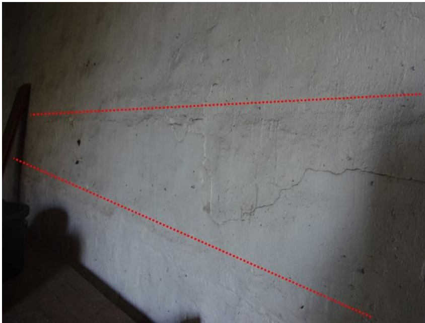
17. Aftekeningen van de regels waaraan de kribben en ruiven waren bevestigd.
