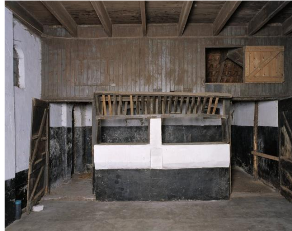
23 – 24. De onbeschilderde uiteinden van de zolderbalken wijzen op een afgeschoten deel boven de ruiven, zoals dat stond voorgeschreven in het bestek en tevens nog te zien is bij een stalgebouw uit circa 1900 in het Twentse Deurningen (foto: g. Barbiers/RCE)
