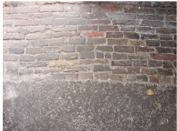
15. Op bepaalde plaatsen is de vloer overdekt met een afgesleten laagje mortel.
