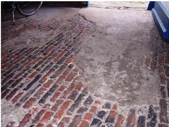
15. Op bepaalde plaatsen is de vloer overdekt met een afgesleten laagje mortel.
