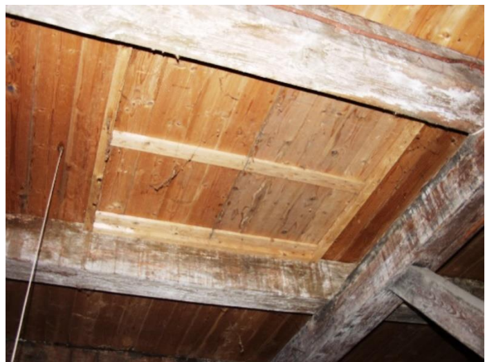
25. Het moderne luik in de zolder van het koetshuis.
