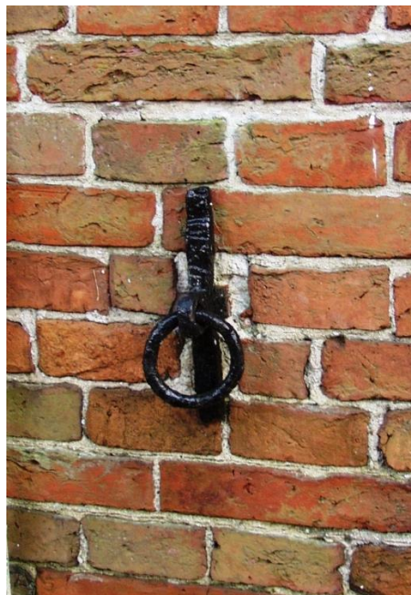
18 – 19. Aan de voorgevel en voormalige achtergevel (rode omkadering) zijn hier en daar nog muurankers zichtbaar waarmee de voerbakken via stijlen en dwarsregels stevig waren vastgezet. De ankers aan de straatkant hebben hun ringen nog behouden waaraan een paard kon worden vastgezet.
