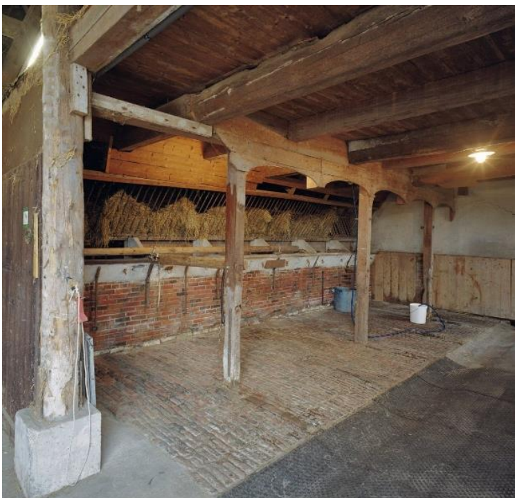
38. De paardenvoergang in een van de bijschuren van de rijksmonumentale boerderij Andelsterweg 2 te Rasquert vertoont overeenkomsten met het Punter exemplaar. Wel is de bakstenen basis hier niet schuin maar gewoon rechtstandig opgetrokken. Karakteristiek zijn de sierstukken die in veel Groninger en Friese paardenstallen werden aangetroffen. Zo te zien waren de voorzieningen in 2004 – het jaar dat de foto werd gemaakt – nog volop in gebruik. En waarom ook niet? (foto: Gerard Dukker/ RCE)
