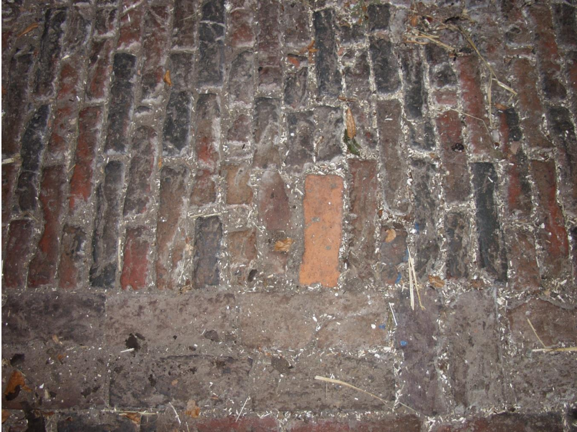
14. Mogelijk valt in deze met andere stenen dichtgezette plek de standplaats van een stalpaal te zien.
