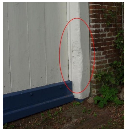
9. Haken om het tuig aan op te hangen. 10. Knaagsporen aan deurstijl dubbele wagenpoort
