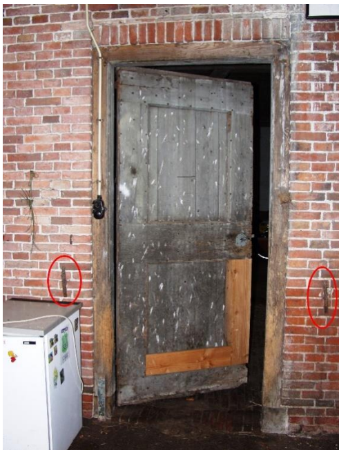
18 – 19. Aan de voorgevel en voormalige achtergevel (rode omkadering) zijn hier en daar nog muurankers zichtbaar waarmee de voerbakken via stijlen en dwarsregels stevig waren vastgezet. De ankers aan de straatkant hebben hun ringen nog behouden waaraan een paard kon worden vastgezet.
