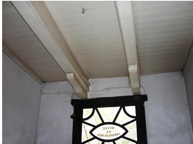
17. Sleutelstukken balken centrale hal.
