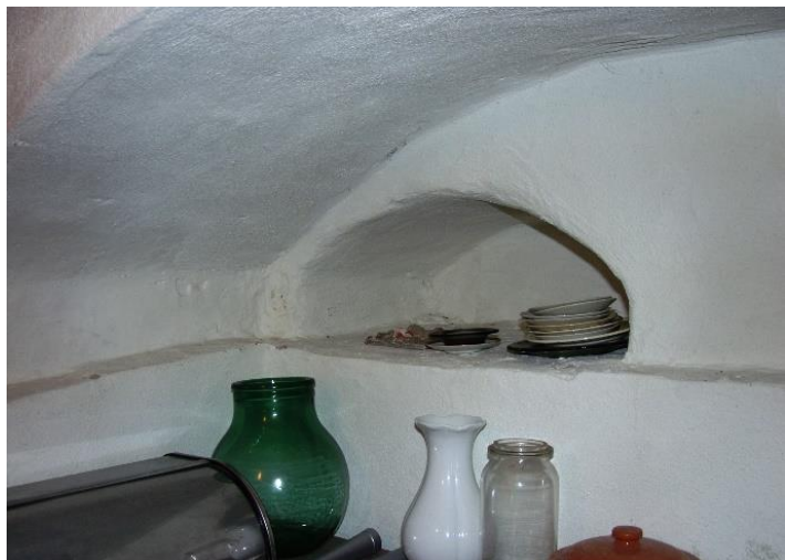
21. 'Extra' funderingsmuur kelder
