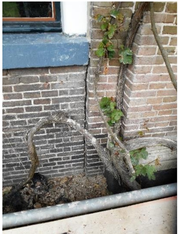
63 – 64. Klezoren in een oorspronkelijk deel van de gevel (rechterhoek) en een vervangen gevelvlak (onder het venster links van het middenrisaliet)
