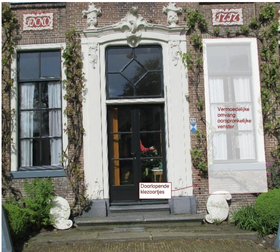
36. De vensters op de begane grond zijn een stuk langer geweest.
