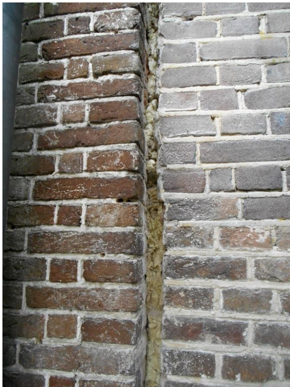
63 – 64. Klezoren in een oorspronkelijk deel van de gevel (rechterhoek) en een vervangen gevelvlak (onder het venster links van het middenrisaliet)
