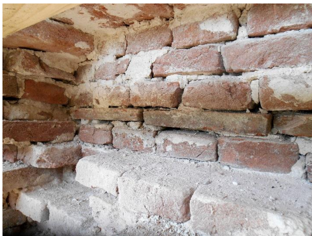
18. Het muurwerk boven de entree laat eveneens sporen van wijzigingen zien, die blijkbaar nodig waren om de hoogte of de constructie van de deurkozijnen aan te passen.
