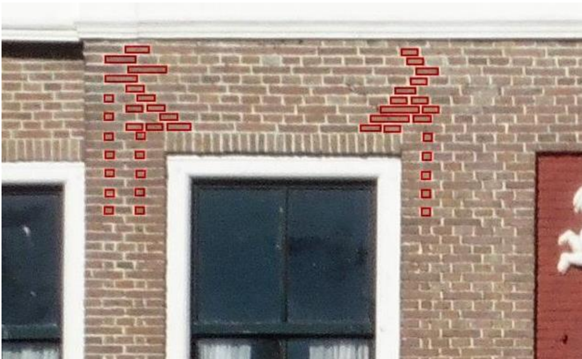
16. Foto van voor de restauratie. Aan afwijkingen in het metselverband is te zien dat de bovenkant van het middenrisaliet is aangepast, met gebruikmaking van de oude stenen. Niet voor niets zijn op deze plek veel inboetingen verricht.
