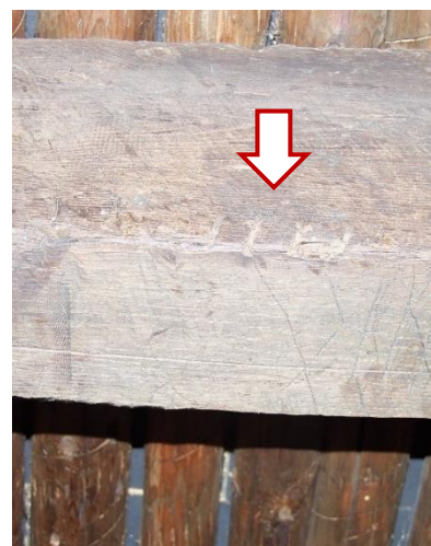
80. Gehakt telmerk V op vijfde gebintstijl en schoren noordzijde.
