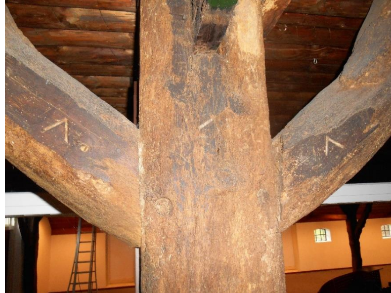
80. Gehakt telmerk V op vijfde gebintstijl en schoren noordzijde.
