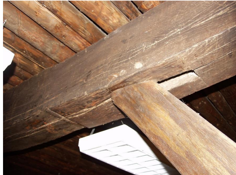
71 - 72. Aan de zuidzijde heeft de vierde ankerbalk alleen een klein profielrandje. Het 'korbeel' is modern en past dan ook slecht.
