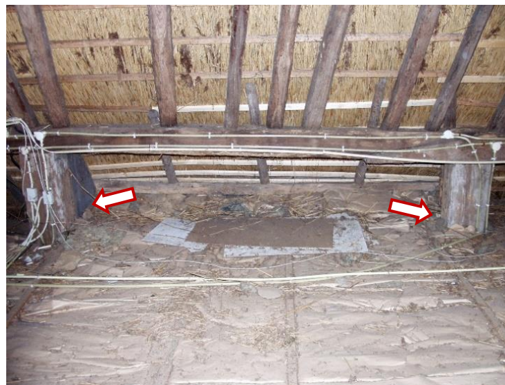
50. Op zolder is te zien dat in het vlak van de baander de gebintstijlen geen schoren hebben.
