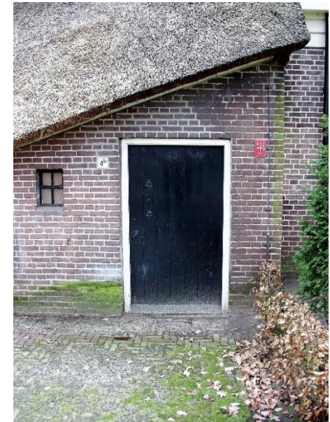
40. Oplopende daklijn met entree naar de voormalige pompstraat.
