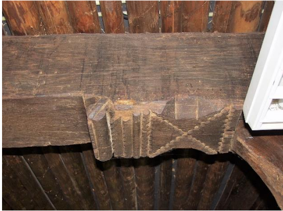
68 – 70. Nogmaals het 'sleutelstuk' van diverse kanten.
