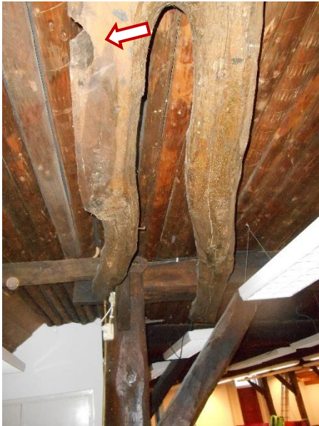
51 - 52. De gaffelvormige balk boven het eerste gebintvak, noordzijde. Bij de pijl het halfronde gat voor de rosmolen.
