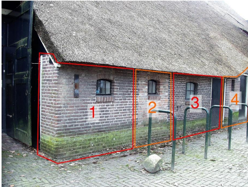
39. Verschillende bouwfases noordgevel: 1: nieuw opgetrokken in eerste helft 20 ste eeuw. 2: Dichtgezet deurvenster, vermoedelijk kort na WOII. 3. Origineel stuk gevel uit 1813. 4. nieuw opgetrokken, vermoedelijk rond 1900.
