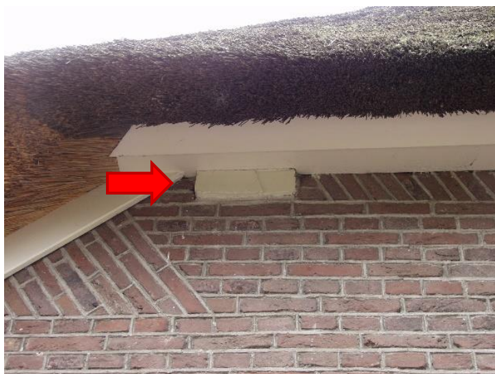
33. De afgezaagde gebintplaten zijn te zien aan de buitenkant van de gevel uit 1964.
