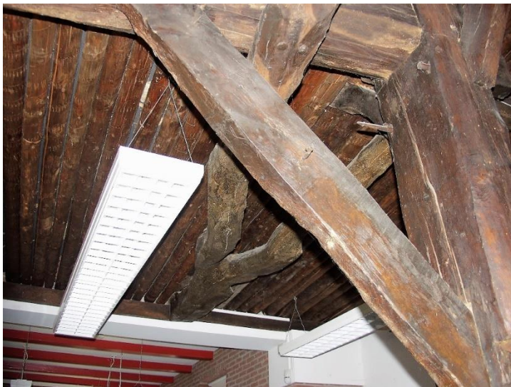
51 - 52. De gaffelvormige balk boven het eerste gebintvak, noordzijde. Bij de pijl het halfronde gat voor de rosmolen.
