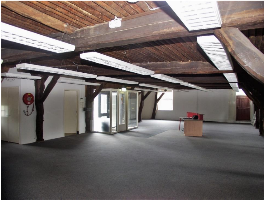
48. Binnenruimte gezien naar het oosten.
