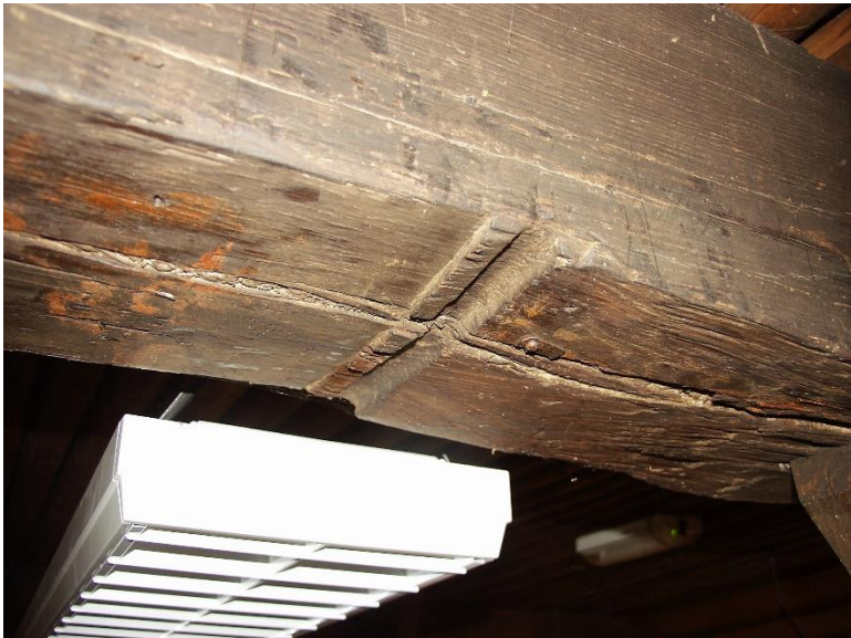
71 - 72. Aan de zuidzijde heeft de vierde ankerbalk alleen een klein profielrandje. Het 'korbeel' is modern en past dan ook slecht.
