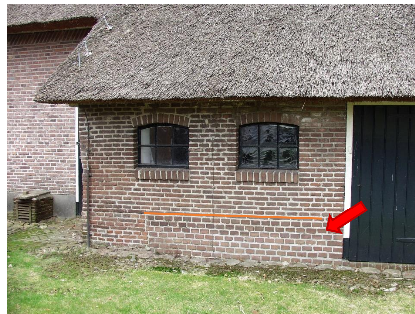
28. Onderin de gevel zit een laag vormbakstenen in kops verband.
